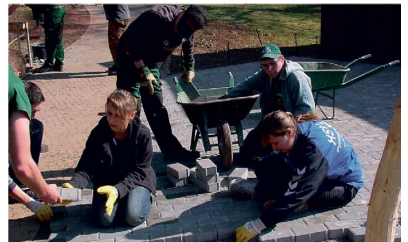
Beim Projekt Zeitspende haben Mitarbeiter der UKV-Krankenversicherung die Lebenshilfe Obere Saar beim Terrassenbau unterstützt. FOTO: HANS JOACHIM MÜLLER
